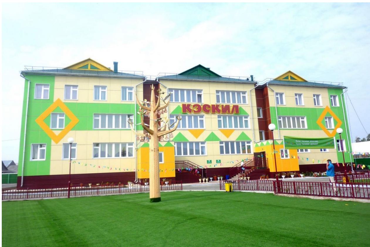
Детский сад «Кэскил» на 240 мест в г. Якутск.
